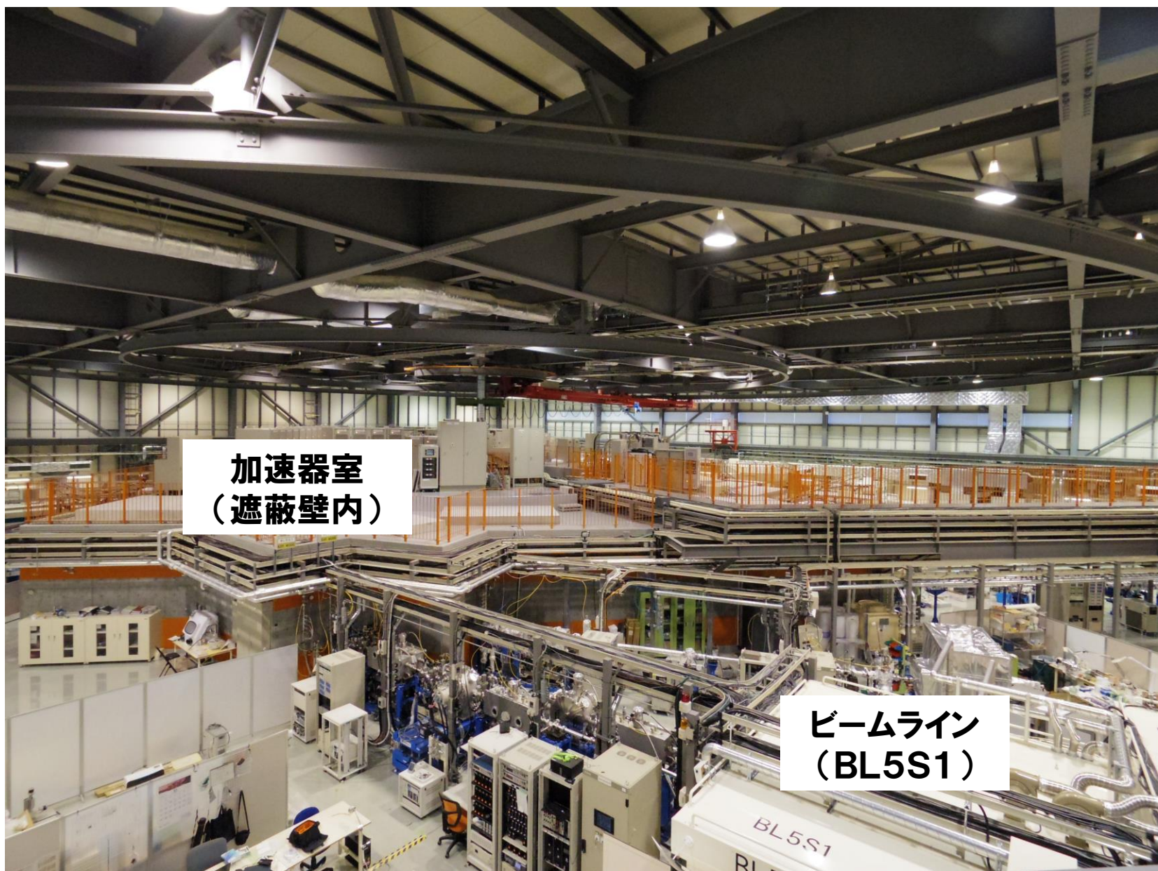
あいちシンクロtron光センター 実験ホール
