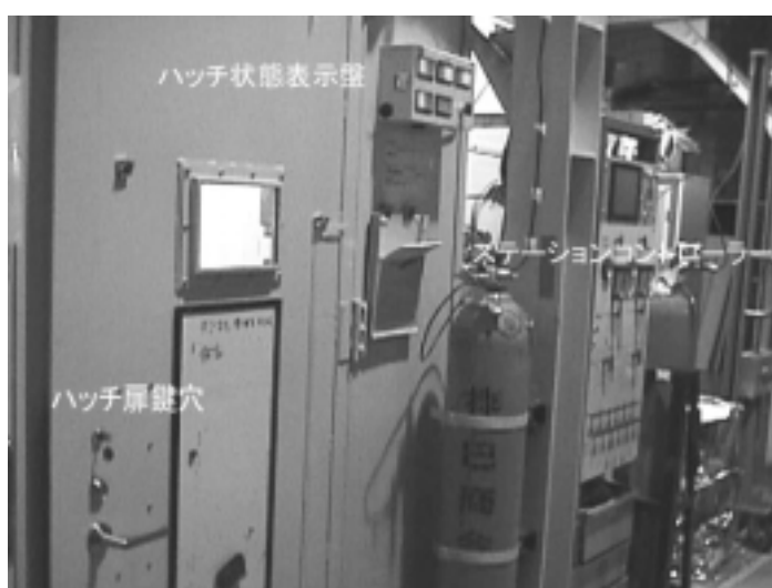
図 3.1.1 インターロック外観。ハッチ内に退室制御装置がある。
